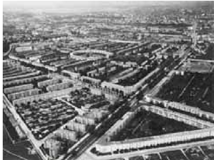
Großsiedlung Britz, Luftaufnahme, o. J., Museum Neukölln
